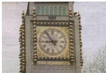
Сама башня тоже сделана из толстолистового металла с большим запасом прочности. Ее поверхность резная, сделана методом двухслойного листа, а сверху покрыта специальной краской с 10-летней гарантией. Башня высокотехнологичная, внутри полая, с лестницами, площадками, доступом к часовому механизму. Ее ночное освещение устроено на светодиодных лампах, которые экономят электричество.
